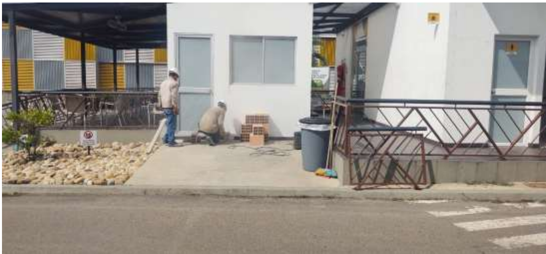
Imagen 1. Exterior de la zona de cafetería.
